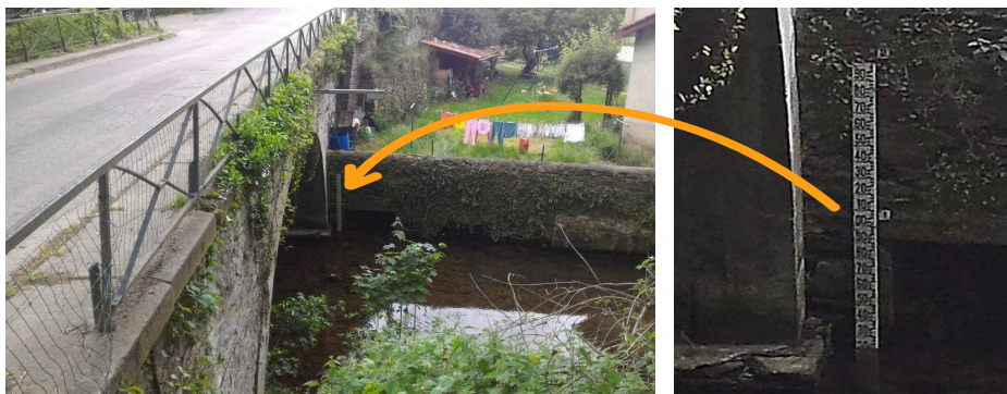
Station de mesures située aux Fabriques
